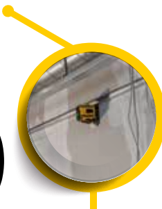
Arbeiten an U-Profilen
